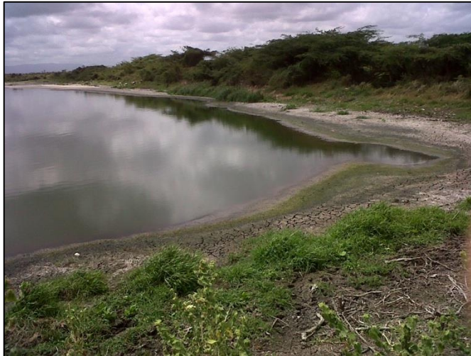
LAGUNA DE OXIDACIÓN DE LIMONCITO
