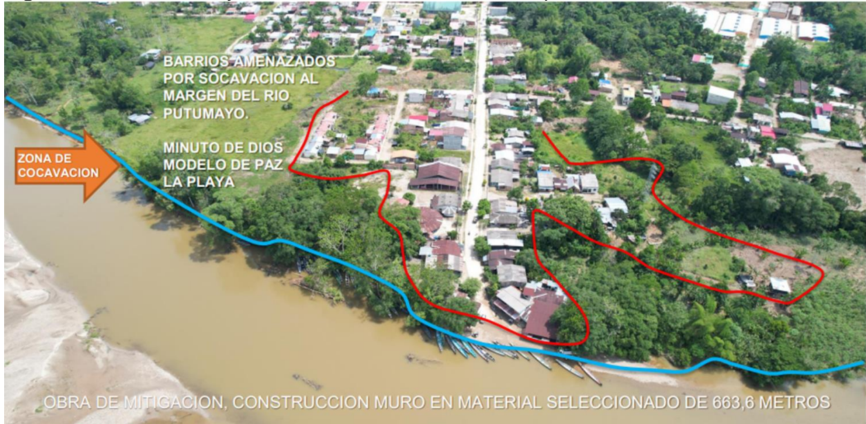
Figura 15. Sector La Playa de Puerto Caicedo, amenazado por la socavación lateral
